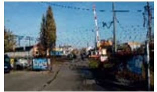
3. Przywrócenie przejazdu kolejowego dla ruchu kołowego
