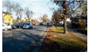
2. Budowa nawierzchni i ścieżki rowerowej od ul. Broniewskiego do ul. Dziewińskiej „Ku Wiśle”
