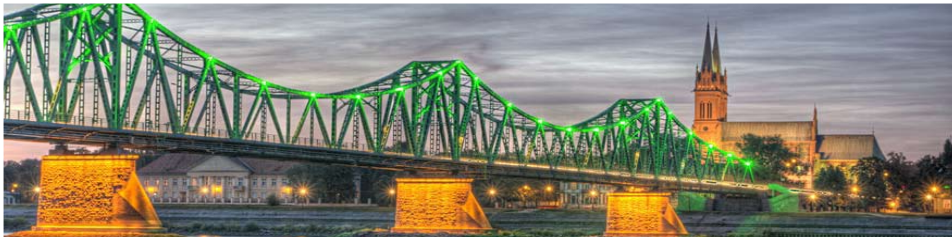
Przebudowany most im. marszałka Śmigłego -Rydza wraz z iluminacją
