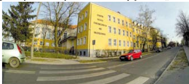
Nowa elewacja w Zespole Szkół Chemicznych
