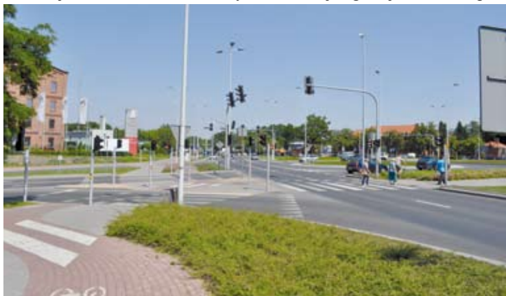
W latach 2009 – 2014 Przebudowano odcinek liczący ok. 11 km na drodze krajowej nr 1 (obecnie DK91). To największa drogową inwestycja w historii Włocławka!
