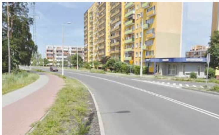
W 2010 roku zakończono przebudowę ulicy Fredry na odcinku ul. Zgodna – ul. Gajowa.
